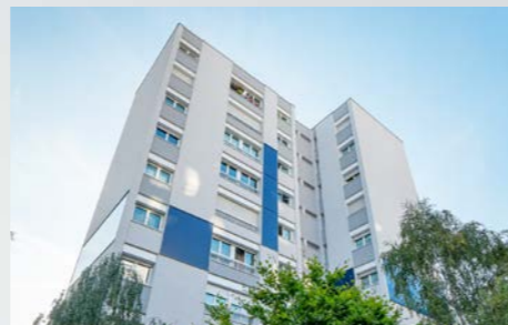
7, rue Lavoisier - Créteil
